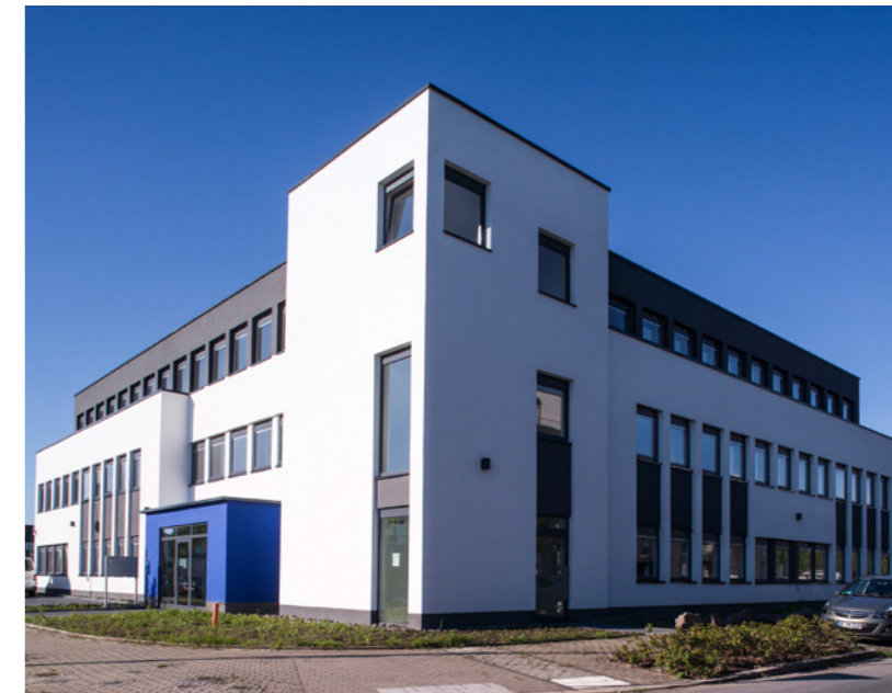
In diesem Pilotprojekt in Dortmund kommen bereits von VEKA selbst entwickelte Steuerungen und Schaltkontakte zum Einsatz
